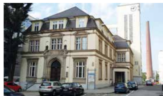
Die ‚Campus Kulmbach-Anlaufstelle‘ in der Fritz-Hornschuch-Straße 13.
